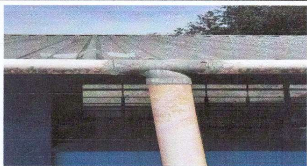
Foto 3: Sustitución de canal de PVC + Sustitución de bajada de agua pluvial de metal por tubo PVC 3" + Sustitución de soporte o pescante de metal para canal
